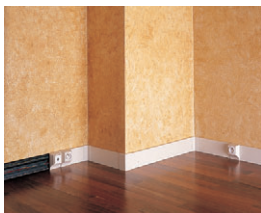
Instalacja w listwie z PVC
