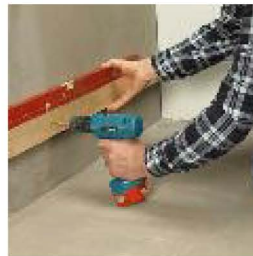
Poziomowanie (rektyfikacja) i mocowanie łąty drewnianej, pełniącej funkcję podwaliny montażowej pod płytki na ścianie
