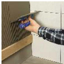
Układanie zaprawy klejowej pacą zębatą.
