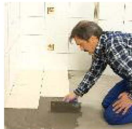
Układanie zaprawy klejowej na podłodze. Paca zębata pod kątem 45°.
