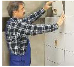
Montaż płytek okładzinowych na ścianie
