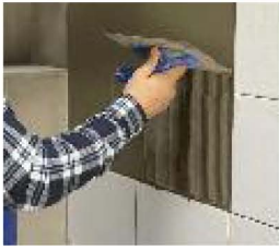
Układanie zaprawy klejowej na ścianie
