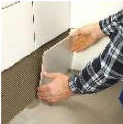
Montaż płytek cokołowych.
