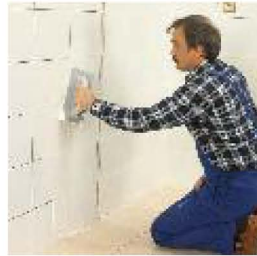
Wprowadzanie zaprawy do spoinowania w szczeliny między płytkami przy pomocy pacy do fugowania.
