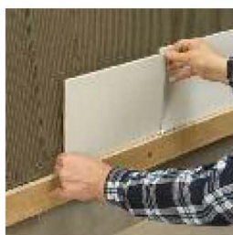
Montaż płytek, pierwsza warstwa na łacie drewnianej.
