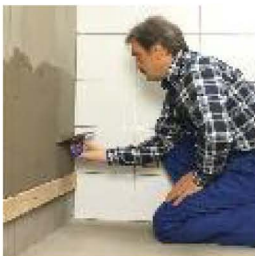
Wyrównywanie, szpachlowanie ściany
