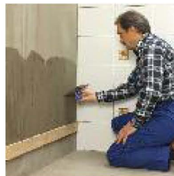
Wyrównywanie, szpachlowanie ściany
