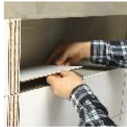
Montaż płytek we wnęce.
