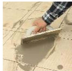
Spoinowanie (fugowanie) płytek na powierzchni poziomej.
