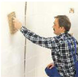
Kształtowanie spoiny przy użyciu pacy z gąbką oraz wody.
