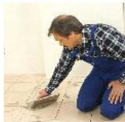
Spoinowanie (fugowanie) płytek na powierzchni poziomej.
