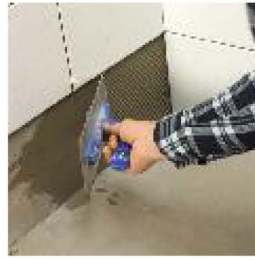
Po zdemontowaniu łąty bazowej, układanie zaprawy klejowej pod płytki cokołowe.
