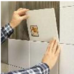
Montaż płytek okładzinowych na ścianie
