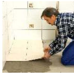
Układanie płytek. Krawędź układanej płytki styka się z rantem płytki umocowanej. Po przyłożeniu całej powierzchni płytki odsuwamy ją o szerokość spoiny. Zaprawa klejowa nie jest wyciskana między płytki.
