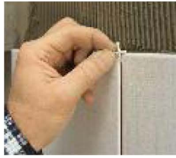
Mocowanie krzyżyków dystansowych na ścianie (ustalenie szerokości spoiny, stabilizacja płytek)
