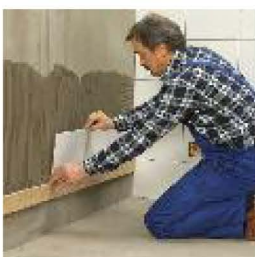
Montaż płytek, pierwsza warstwa na łacie drewnianej.
